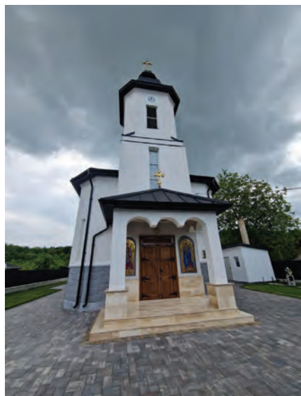
Biserica de zid din Dobricel, construită în anii 1939-1942, care se va resfinți la 30 august a.c., după ample lucrări de renovare.
